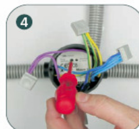
4 De programmeertoets wordt nogmaals ingedrukt, om de procedure af te sluiten (de LED en de aangesloten lamp zijn uitgeschakeld)
